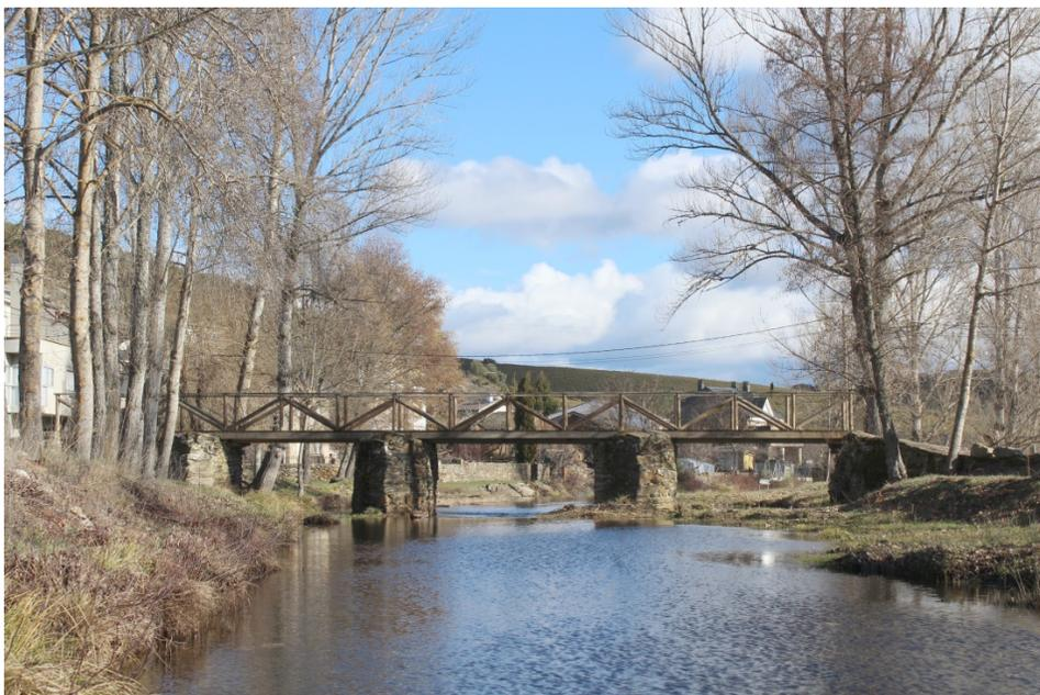
A ponte pedonal, sobre o “Río Manzanas”, de tabuleiro e guardas em madeira, assente pilares de pedra, tradicionalmente construídos para resistir à força da formação de gelo no rio, constitui um elemento de grande valor cultural ligando a aldeia com a margem dos campos agrícolas, usando métodos tradicionais e modernos (Riomanzanas, fevereiro de 2018).
