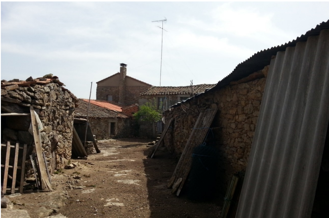
Figura 19 – Conjunto edificado na mesma parcela – Edifício de habitação, arrumos e apoio agrícola - Fariza
