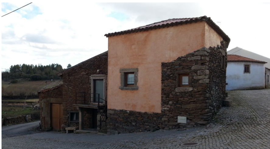
Figura 31 – Exemplo de parede exterior rebocada com terra e cal e com pedra à vista - Atenor
