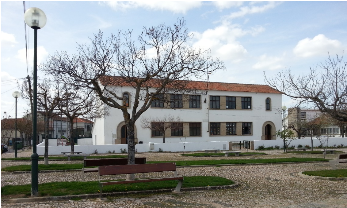
Figura 21 - Equipamento Público – Escola Primária de Bemposta – Bemposta
