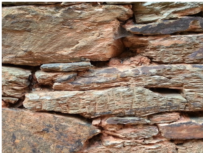
Figura 30 – Exemplo de aplicação de argamassa de assentamento de terra simples - Atenor
